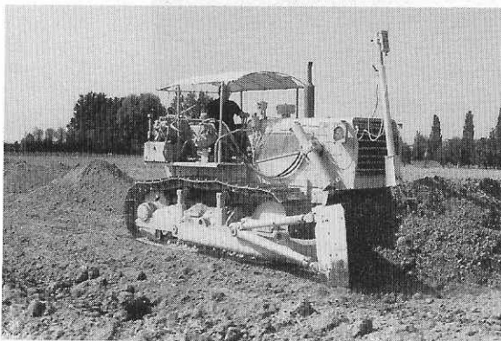
Fig.10 In questa foto si può vedere una ruspa già provvista di un'asta di riferimento con dei fotodiodi che provvedono, grazie ad un circuito supplementare, ad alzare o ad abbassare automaticamente la pala in base al livello del fascio Laser.
